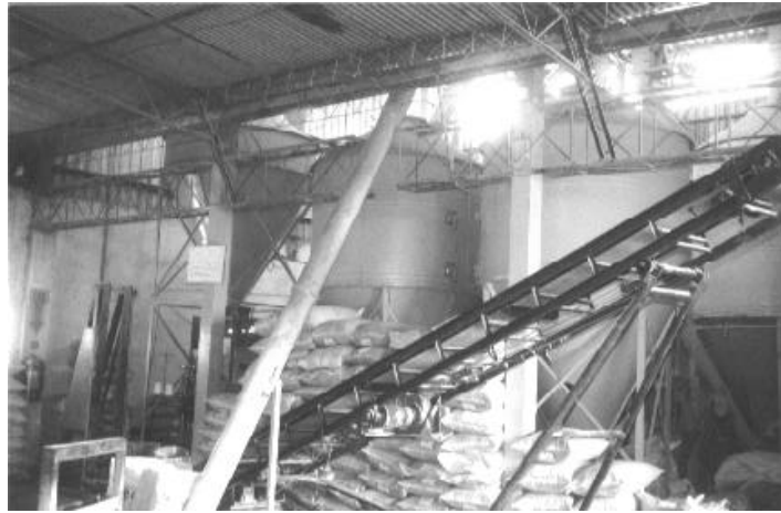
Vista Interna da Fábrica de Rações
