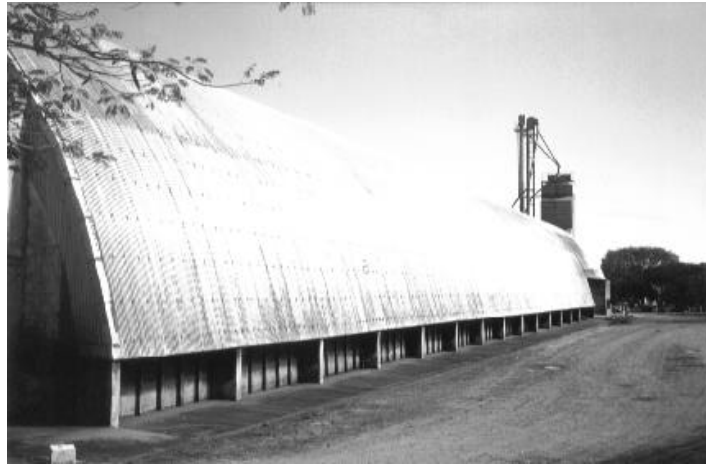
Vista Lateral do Silos
